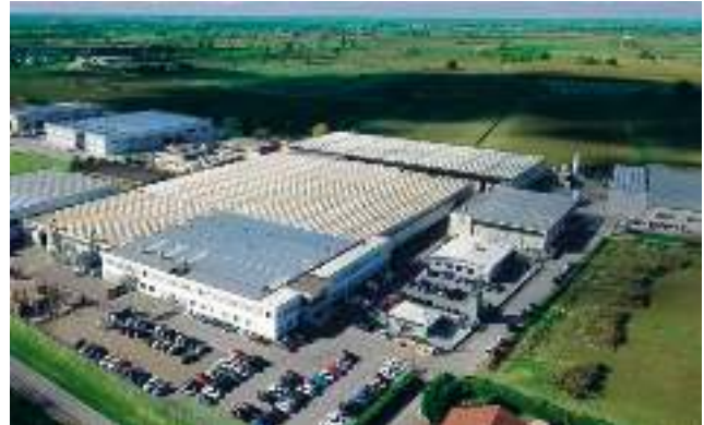
Рис. 1. Главный офис и фабрика Campitello.
