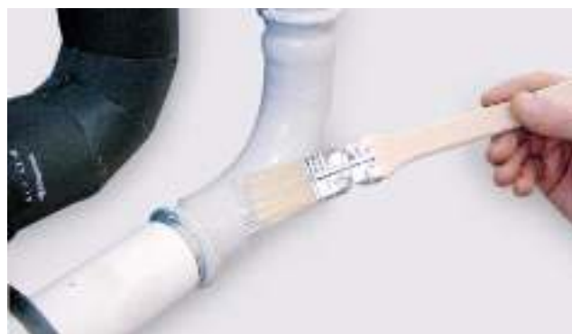
Рис. 37. Покраска соединений и труб праймером.
