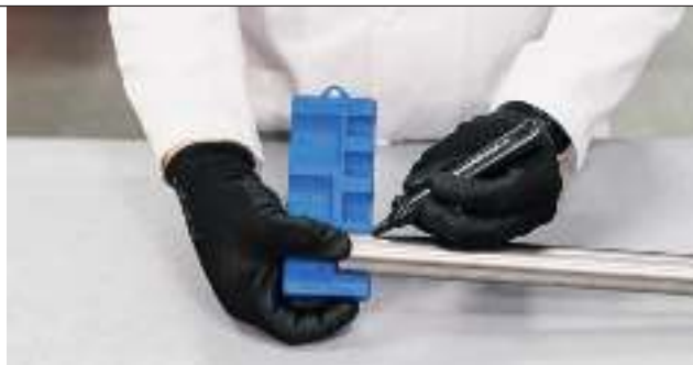
Рис. 28. Маркировка глубины вставки.
