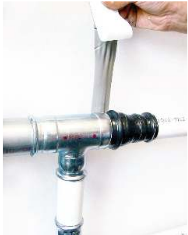
Рис. 38. Защита соединений с помощью бутаноловой клейкой ленты.
