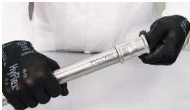
Рис. 31. Вставка трубы в пресс-фитинг.
